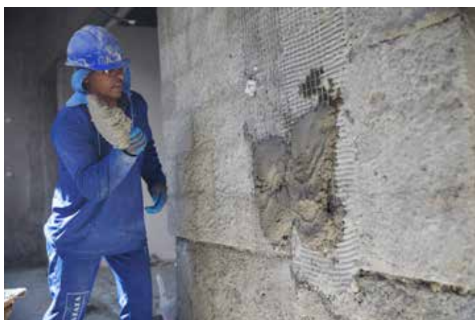
Fig. 24 - Aplicação da argamassa
