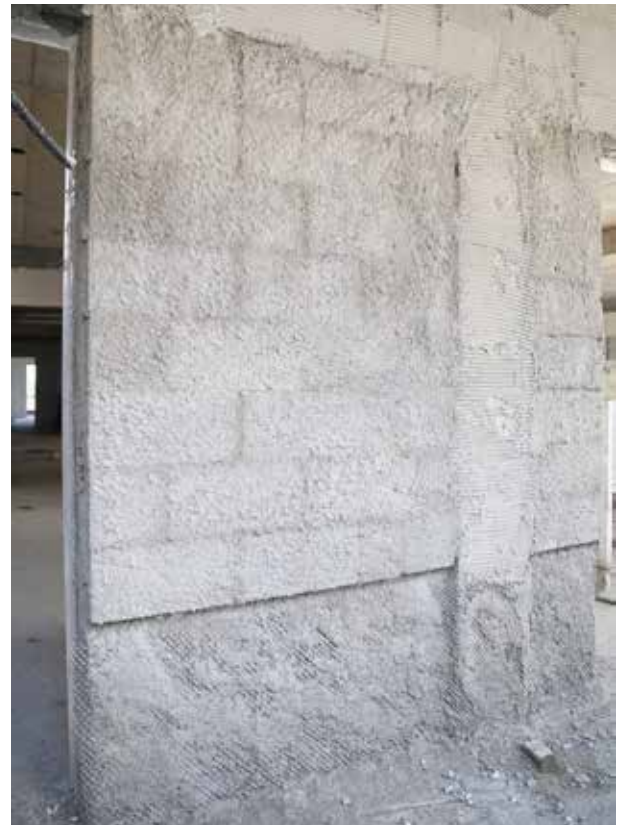
Fig. 11 - Chapisco e alvenaria encunhada
