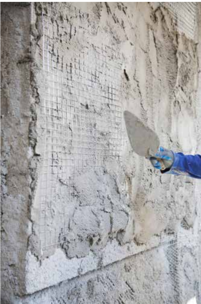
Fig. 33 - Aplicação da última camada de argamassa
