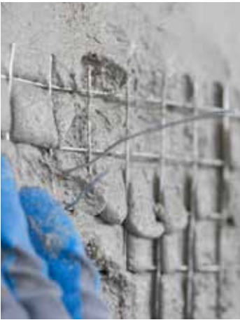
Fig. 30 - Tela penetrando na camada de argamassa
