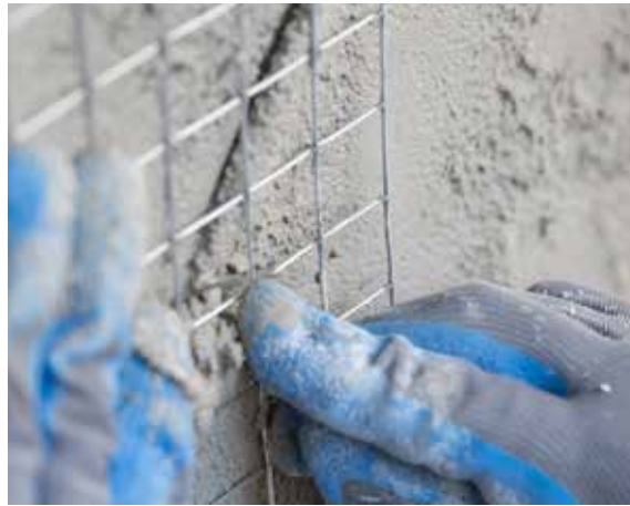
Fig. 31 e 32 - Fixação da tela com os arames
