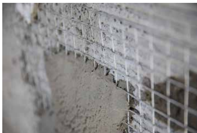
Fig. 25 - Passagem da argamassa através da FACHAFORTE®
