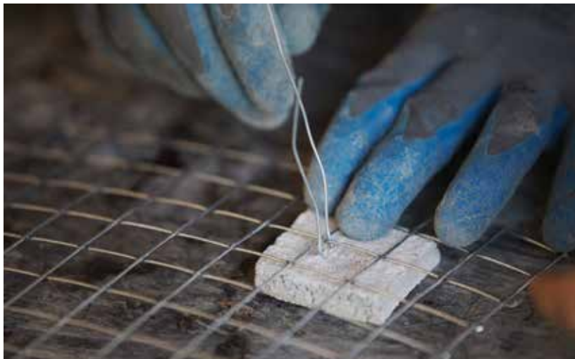
Figura 15 - Posicionamento do espaçador na tela
